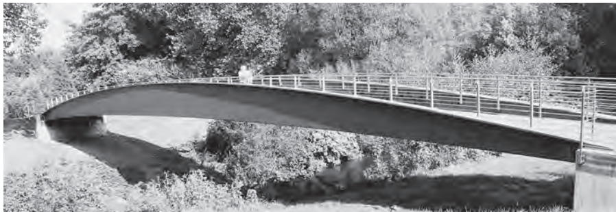
Fußgängerbrücke in den Dhünnauen in Wiesdorf
