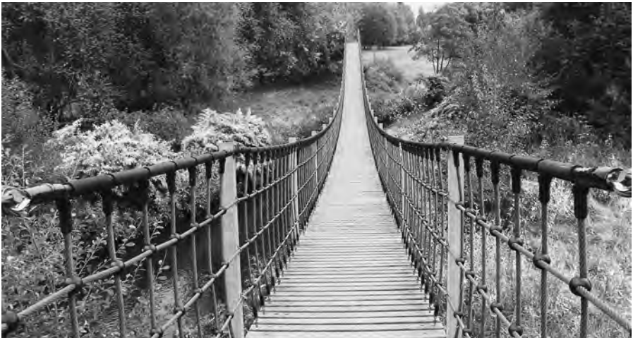
Neulandpark. Die „Wackelbrücke“, eine freischwingende Seilhängebrücke überspannt den renaturierten Abschnitt der Dhünn.
