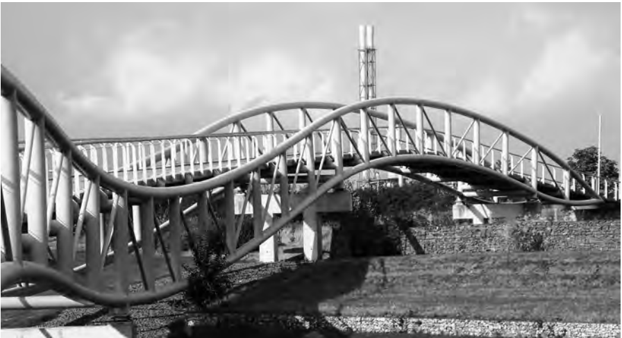
Die Neulandbrücke. Die Fußgängerbrücke über die Rheinallee verbindet den Neulandpark mit dem Rheinufer.
